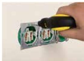
Закрепить блок розеток на коробке (благодаря наличию дополнительных отверстий под шурупы, монтаж можно производить как горизонтально, так и вертикально).
